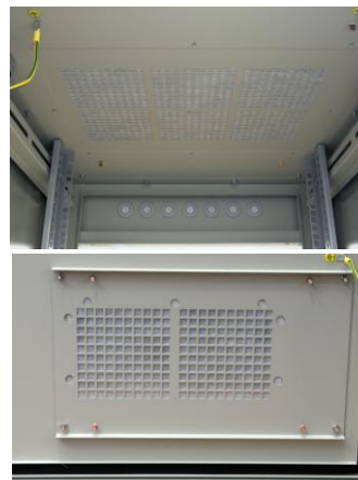
Фото 5: Вентиляционные проемы в потолке и задней двери
